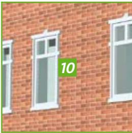
Witterungseinflüsse und der daraus resultierende Feuchtigkeitseintritt in den Untergrund führen zu Schädigungen in der Fassade. Zum Schutz solcher Fassaden aus mineralischen Baustoffen werden Hydrophobierungen eingesetzt, nach denen die Oberfläche wasserabweisend ist. Diese Hydrophobierungsmittel dringen sehr tief ein und trocknen rückstandslos auf, so dass die Optik der Fassade durch die Hydrophobierung nicht beeinträchtigt wird.
