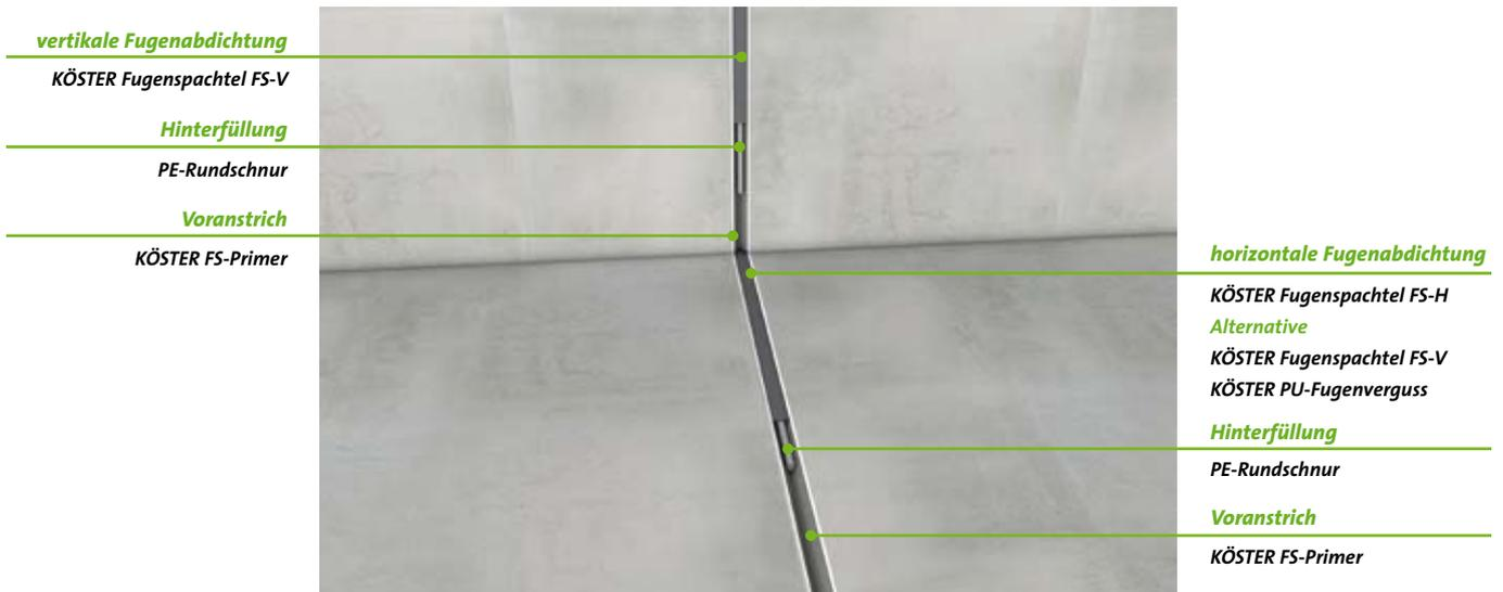
Fugen sind meist thermischen oder anderen Bewegungen ausgesetzt und müssen daher elastisch abgedichtet werden. KÖSTER Fugenspachtel FS ist ein sehr bewährter Fugendichtstoff, der belastbar, UV-beständig und sehr alterungsbeständig ist. KÖSTER Fugenspachtel FS ist auch gegen eine Vielzahl von aggressiven Stoffen beständig.
